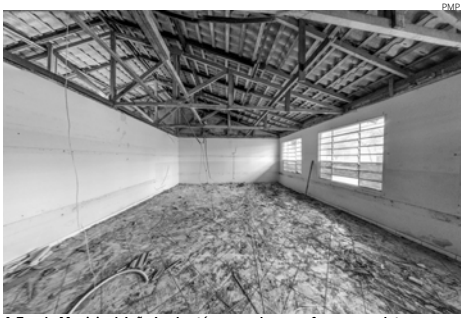
A Escola Municipal João Leal está passando por reforma completa
